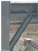
Le bracon est un renfort métallique visant à augmenter la résistance de la charpente. Il est fixé en diagonale, au sommet du poteau et renforce la liaison poteau/traverse.
