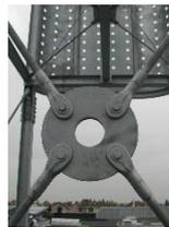
La croix de St-André permet de réduire la pression exercée sur la charpente, de transmettre les efforts horizontaux d'une structure au sol (contraintes naturelles, configuration du bâtiment...) et de maintenir l'équerrage de la structure.
